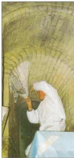
Na volledige droging kan de elastische film die alle vuil bevat worden verwijderd
