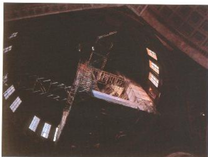
Doordat de draaibare stelling slechts één kwadrant van de koepel inneemt, blijft die grotendeels zichtbaar voor de bezoekers
